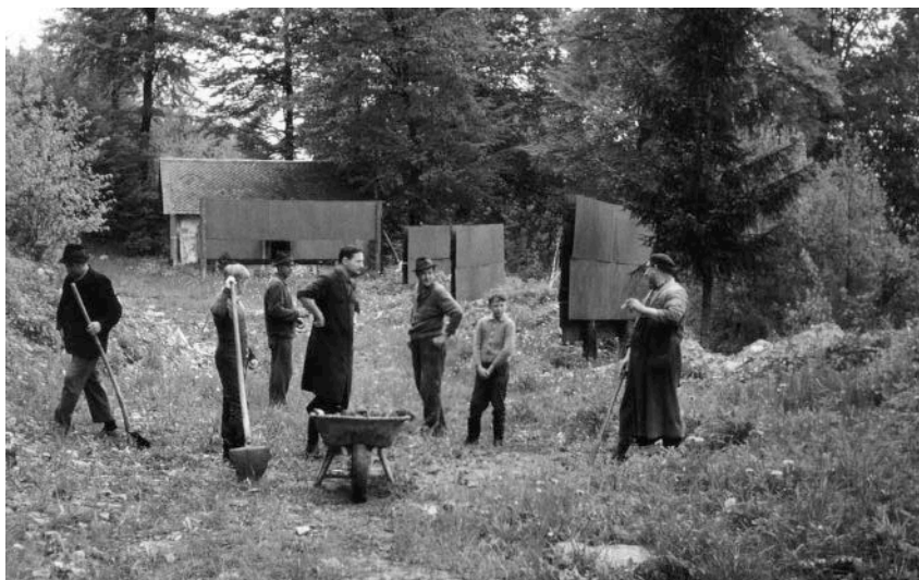
Bau der 50m-Stände, im Hintergrund das Schießhaus
